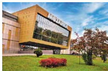
ТРЦ «МОЗАИКА» Общая площадь: 134 000 кв.м. Техническая эксплуатация
