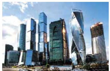
Деловой комплекс Империя г. Москва, Пресненская наб. д. 6с2 Управление и эксплуатация объекта с 2012 года
