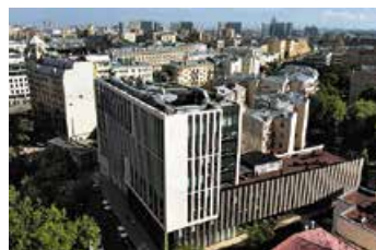
БЦ «Красина, 3» Москва Общая площадь: 11 825 кв.м. Дата начала действия договора: 2017-2021 гг. и с 2022 г. по настоящее время
