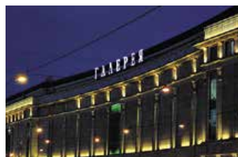
ТРК «Галерея» Санкт-Петербург Общая площадь: 192 000 м 2 Услуги: Техническая эксплуатация, Профессиональная уборка
