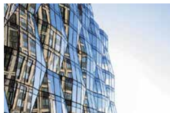
«Искра-Парк» GBA: 76 915 кв.м. NRA: 58 297 кв.м. BREEAM
